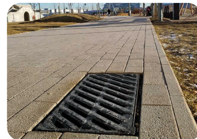
При відсутності антивандального елемента кришка впирається в колодезь і не провалюється
